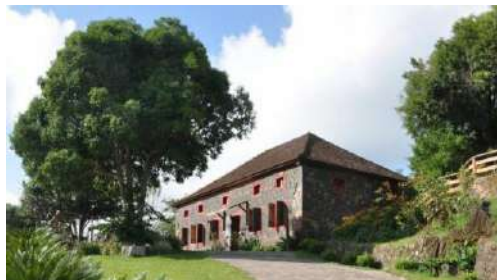
Caminhos de Pedra
